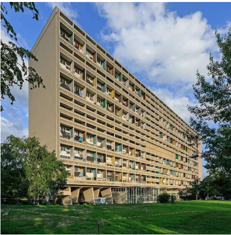
Façade de l'unité d'habitation, Le Corbusier, Berlin, Allemagne, © A. Savin
